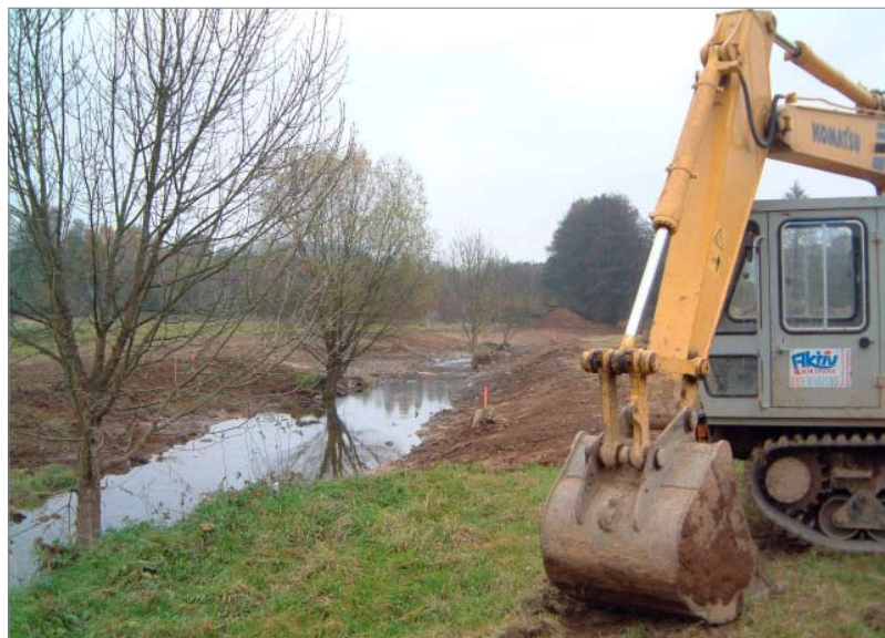
Abb. 2: Ein Schwerpunkt der Verbandsbeteiligung: Maßnahmen zur ökologischen Verbesserungen von Bächen.
