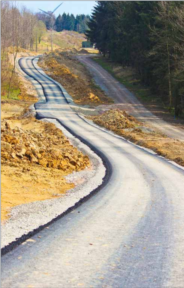
Abb.12: Baumaßnahme Bilster Berg. (Foto: Ulrich Kros)
