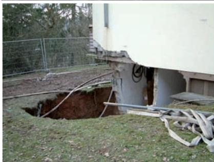
**Abb. 1:** Gebäudeschäden nach einem Erdbeben (o.) und Tagesbruch (u.)
