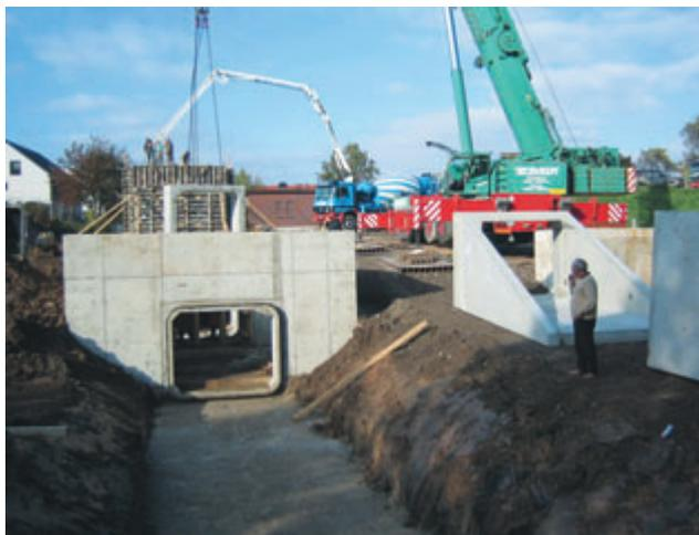
*Schacht und Rechteckprofil des Hochwassersperrtores*
