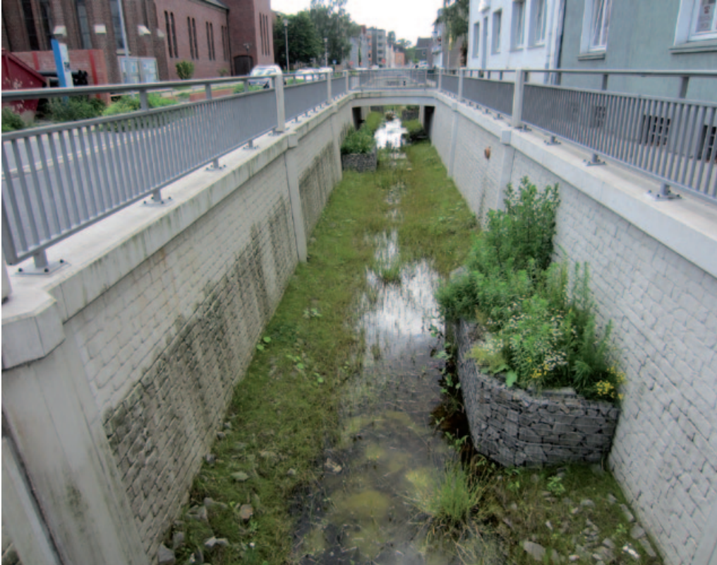
Abb. 32: Öffnung des Deininghauser Baches, Castrop-Rauxel
