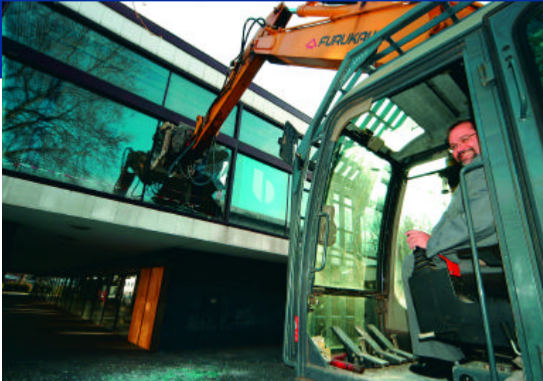
Oberbürgermeister Adolf Sauerland gab als Baggerfahrer den Startschuss für den Abriss der Mercatorhalle.
