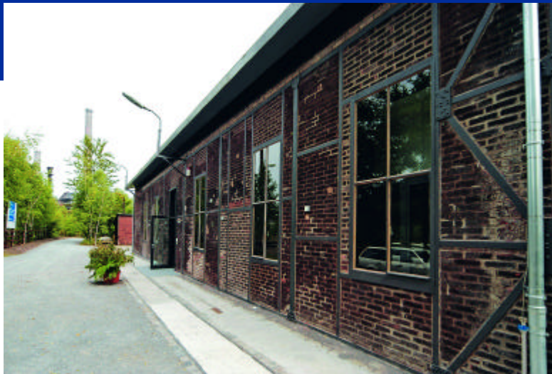
Dependance „Biologische Station Westliches Ruhrgebiet“ in dem Gebäude der ehemaligen Probenentnahme im Landschaftspark Duisburg-Nord.
