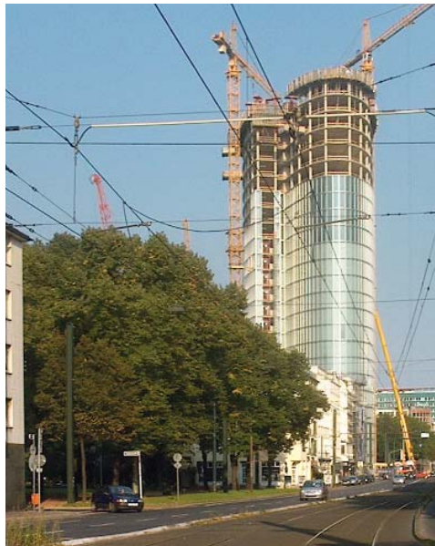
Graf-Adolf-Platz 15 im Bau, Fertigstellung 2005
