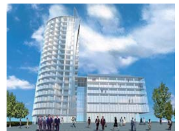
Mediatower Holzstraße (Hafen), im Bau
