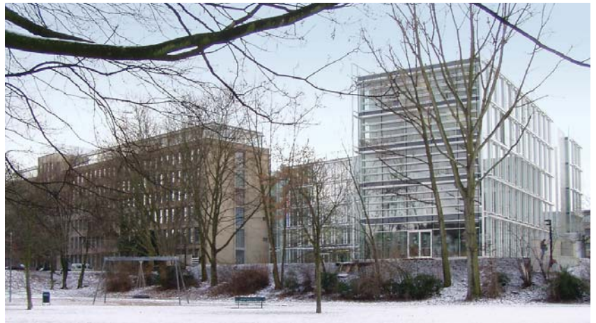
Umbau und Neubau Feldmühle Platz
