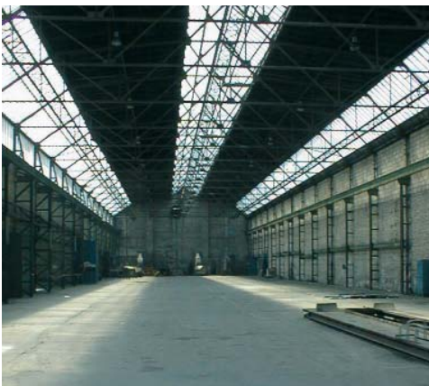
Ehemalige Gewerbehalle in Eller / Sonnenstraße für neue Nutzung
