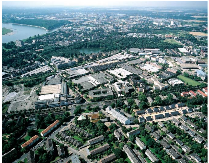
Gewerbegebiet "Hansapark" in Heerdt
