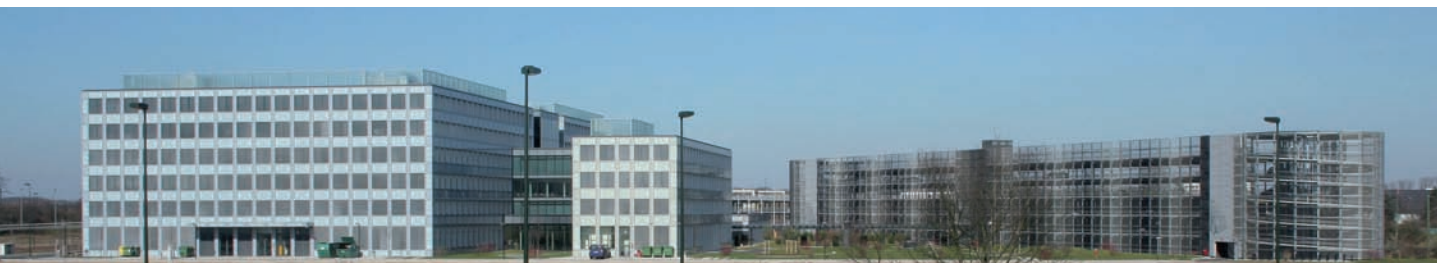
C&A-Zentrale im sogenannten „Quartier“, Wanheimer Straße, Lichtenbroich
