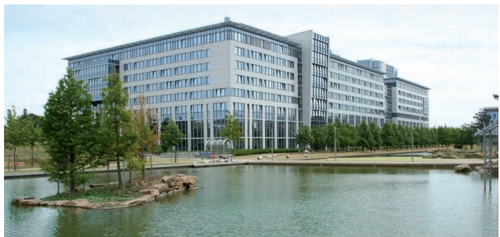
Büronutzung auf dem IHZ-Gelände, Oberbilk
