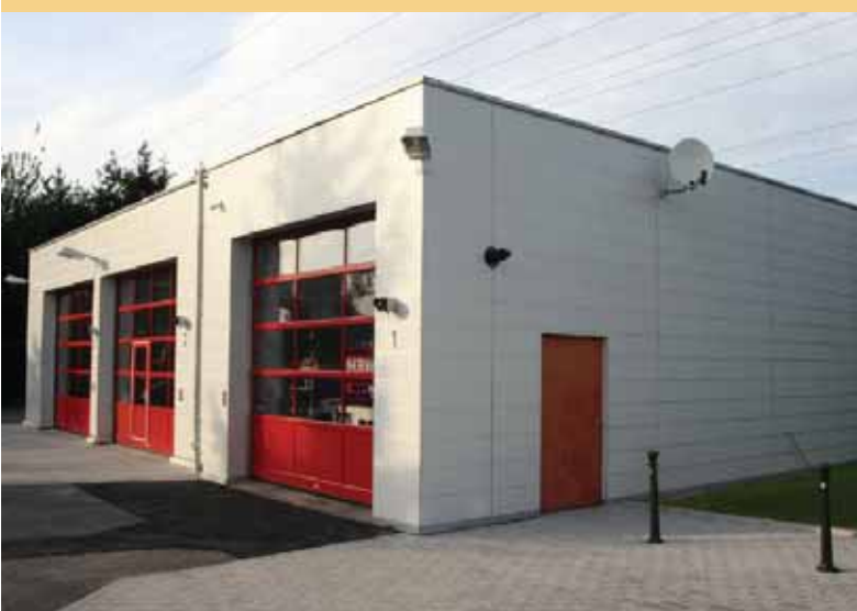
Das Gerätehaus von 1985 wird bis September 2004 um eine neue Fahrzeughalle erweitert, da bis dahin ein Teil der Fahrzeuge im Freien stehen müssen.
