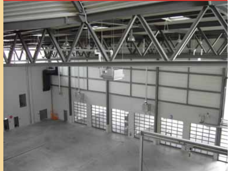
In der Deckenkonstruktion können sich die Höhenretter
