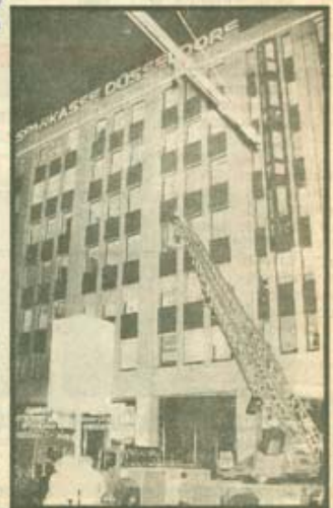
Szenerie nach Mitternacht: Mit Drehleitern suchte die Feuerwehr die Fassade ab.
