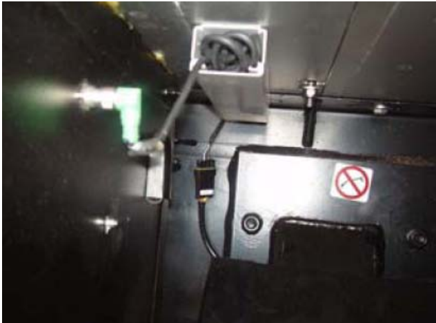
Bild 7: Leitungsverlegung und Steckverbindung
