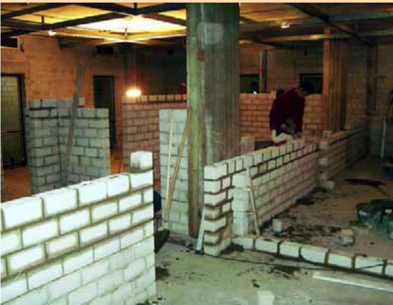
Im Übungskeller werden Zwischenwände gemauert. Es entstehen zwei Wohnungen und eine kleine Werkstatt.
