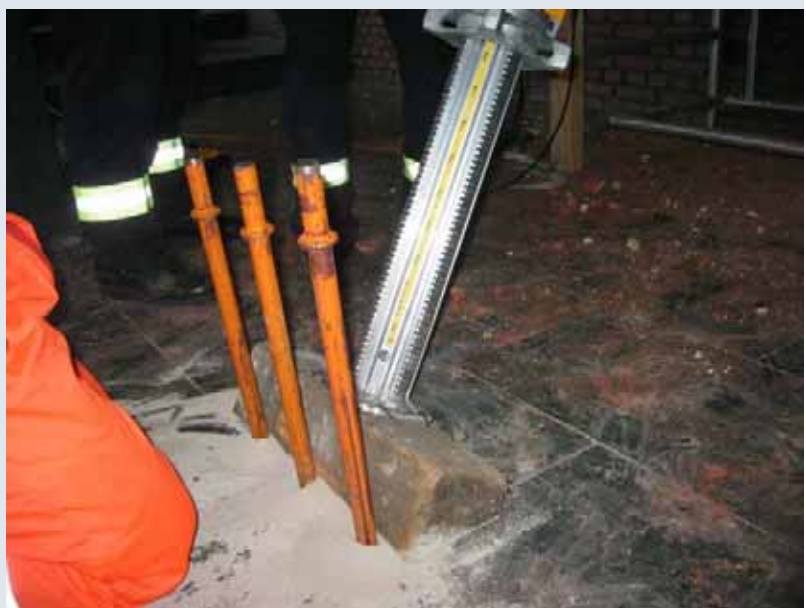
Abstützung mit einer Multiprop-Stütze Auflage und Widerlager der Abstützung
