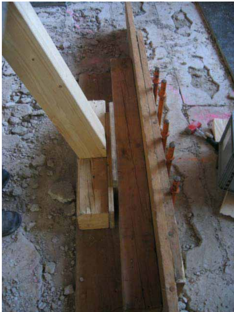
Auflage und Widerlager der Schrägabstütze aus Holz
