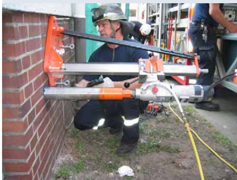
Einsatz des Kernlochbohrers
