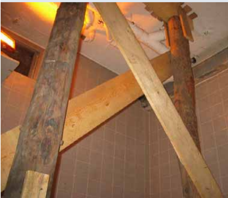
Bild unten: Verkeilung und Sicherung der Stützen auf der Fußfette
