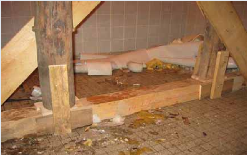
Bild unten: Verkeilung und Sicherung der Stützen auf der Fußfette
