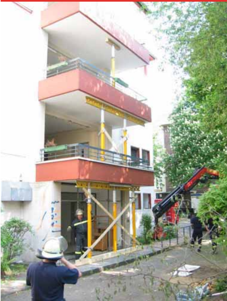
Bild oben: Befestigung der Diagonale an den Metallstützen mit Hilfe von Verschwertungsklammern
