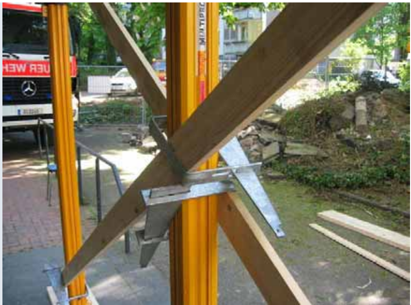
Bild oben: Befestigung der Diagonale an den Metallstützen mit Hilfe von Verschwertungsklammern
