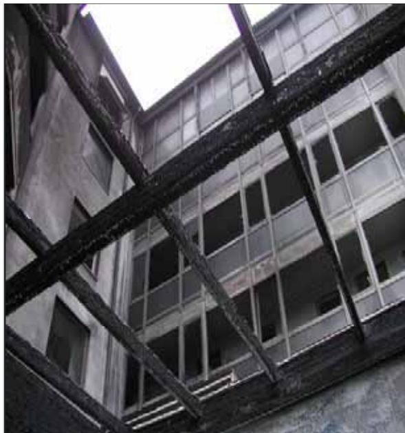
Bild oben: Die vom Feuer beaufschlagten Laubengänge aus Sicht der Brandstelle
