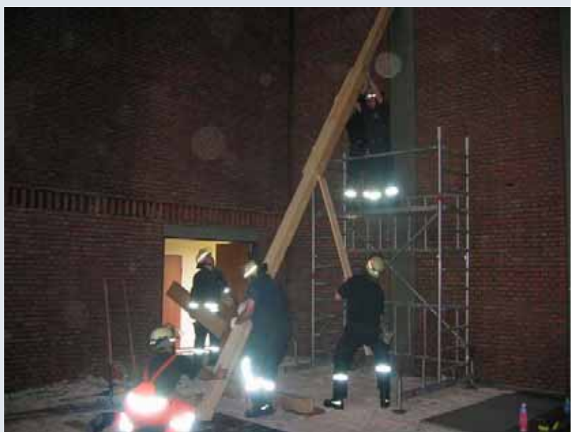
Auflage und Widerlager der Schrägabstütze aus Holz
