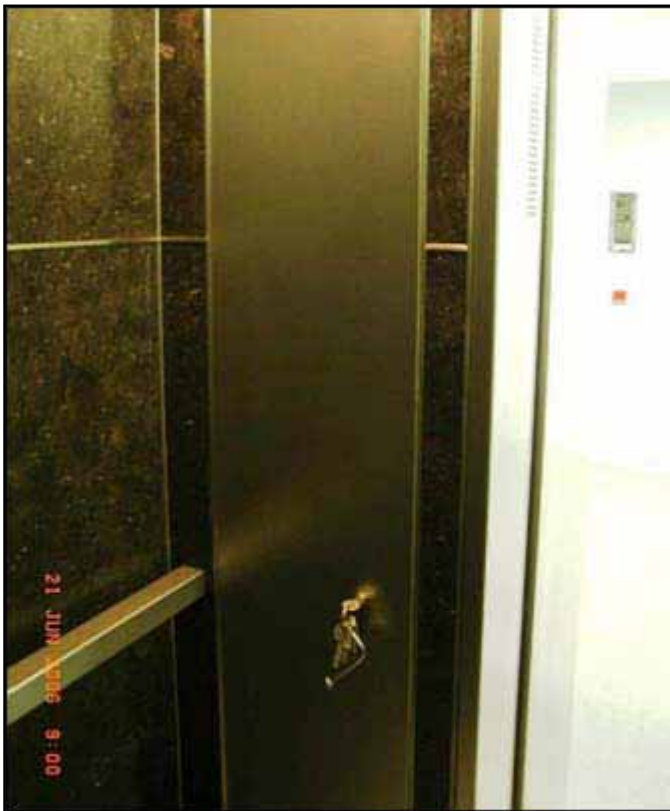
Bilder oben: Bedienfeld für die Feuerwehraufzugsteuerung im Aufzug hinter einer Klappe
