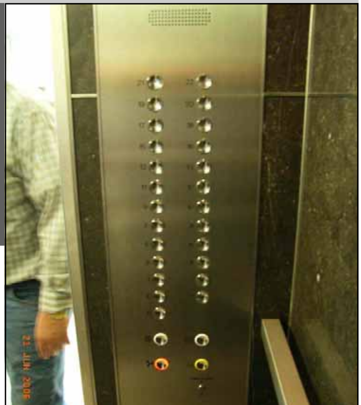
Bild unten: Bedienfeld für die „normale“ Aufzugsteuerung im Aufzug
