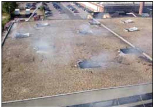
*Durchgebrannte Lichtkuppeln bzw Rauch- und Wärmeabzugsklappen*
