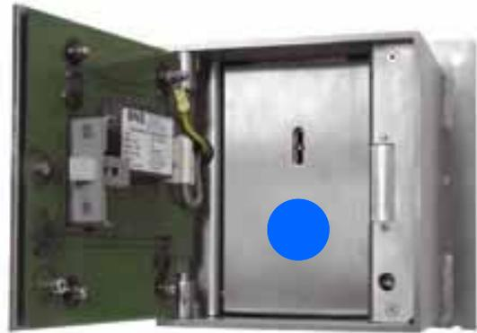
„FSD-A- neu“ mit geöffneter erster Klappe und blauem Punkt auf der zu öffnenden Klappe
