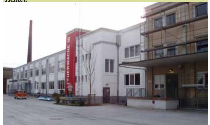
Umbau und Sanierung der Feuerwache 10 verlaufen planmäßig.
