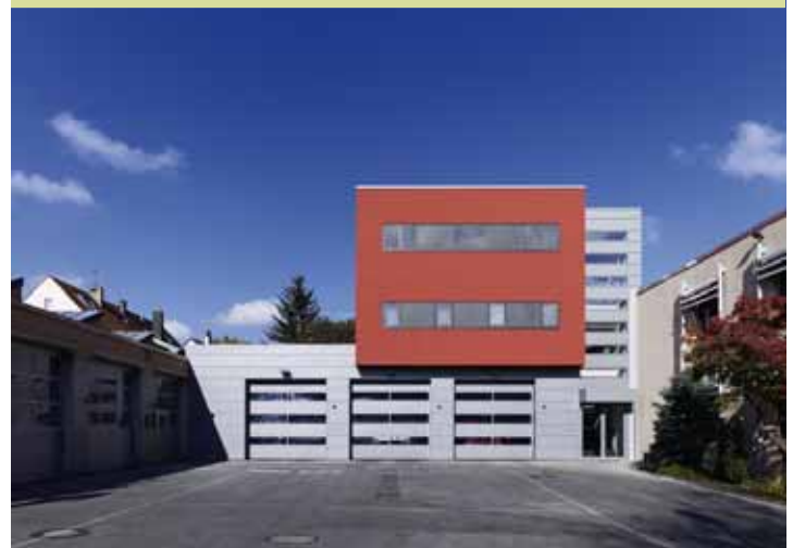
An der Feuer- und Rettungswache 8 wurde ein Verbindungsbau zwischen Fahrzeughalle und eigentlichem Wachgebäude abgerissen und dort ein teilweise dreigeschossiger Neubau mit Fahrzeugstellplätzen sowie Sozial- und Büroräumen neu errichtet.
