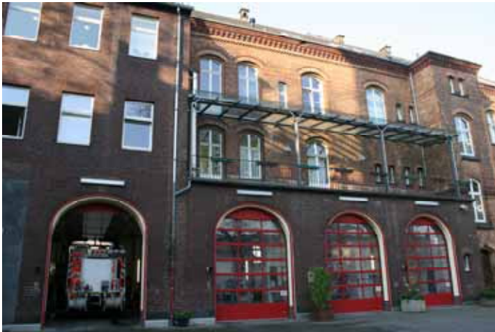
Das Hauptgebäude der Feuer- und Rettungswache 1 wurde komplett saniert.
