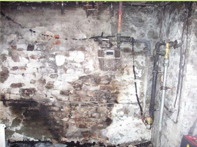
Bei dem Kellerbrand an der Langerstraße wird eine Gasleitung ausgelötet und undicht.
