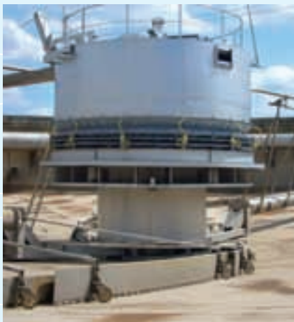
Ausführungsbild eines höhenverstellbaren Einlaufbauwerks »hydrograv adapt«
