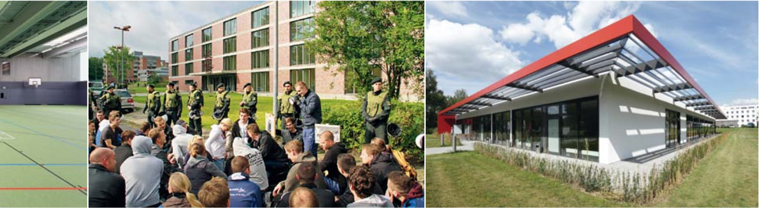
großzügige Sporthalle. In der Liegenschaft trainieren die angehenden Kommissare auch das angemessene Verhalten bei Demonstrationen (M.). Die Auf-Brühl, in dem Kantine und Sanitäräume (Fotos u.) untergekommen sind. Fotos: Lindner Lohse Architekten, G. Rohmann/LAFP NRW, pbr AG/A. Hartmann
