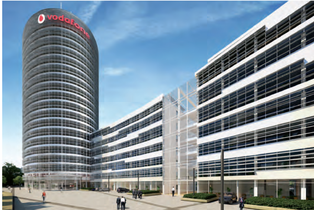
Der neue „Vodafone Campus“ in Düsseldorf-Heerdt.
