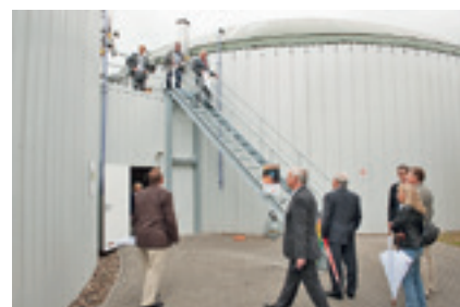
Biogasanlage versorgt Stadtteil Dormagen Hackenbroich
