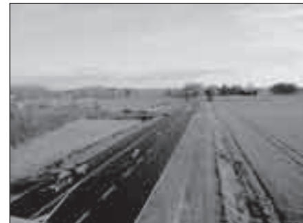
Der neue Radweg entlang der B1 wurde 2005 fertig gestellt.
