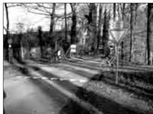
... und die Veloroute nach dem Umbau
